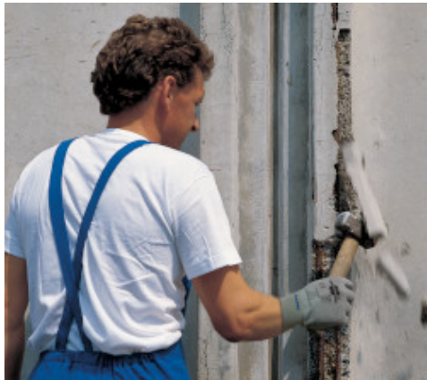
Αποξήλωση αποσπασθωμένου σκυροδέματος
