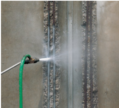
Καθαρισμός ράβδων οπλισμού
